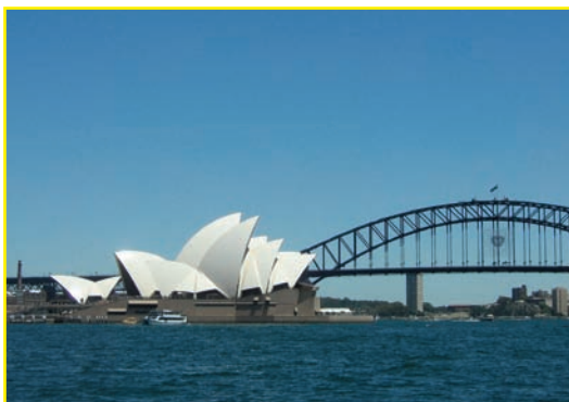
↳ L'opéra de Sydney (Jørn Utzon, architecte).
