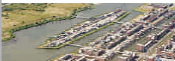
▲ Damkwartier Zeebourg à Amsterdam (Pays-Bas).
