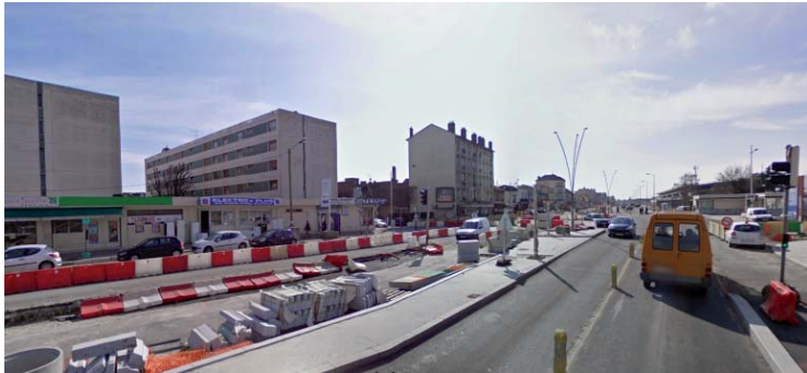
↳ Vue depuis l'avenue du 8 Mai 1945 [a]
