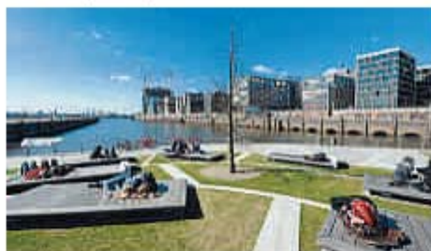
▲ La protection des berges à Hambourg : Hafencity, un quartier inondable et urbain.
